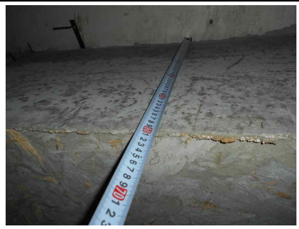
지상5층 바닥 보 G4 규격 조사 현황
