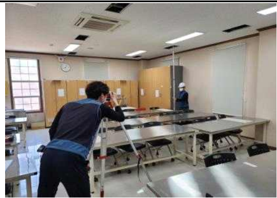
지상2층 상부 부재 수직 변위 조사 현황
