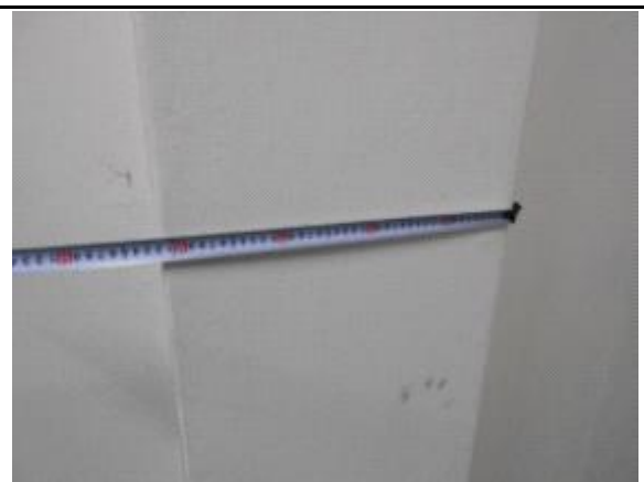
지하1층 기둥 C3 규격 조사 현황
