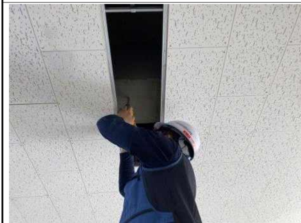
보 하부 콘크리트 압축강도 조사 현황
