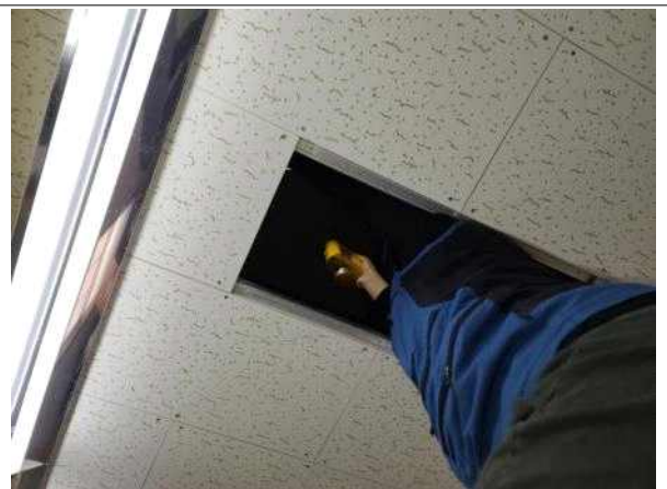
슬래브 콘크리트 압축강도 조사 현황
