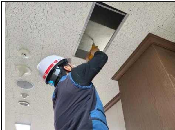
보 하부 콘크리트 압축강도 조사 현황
