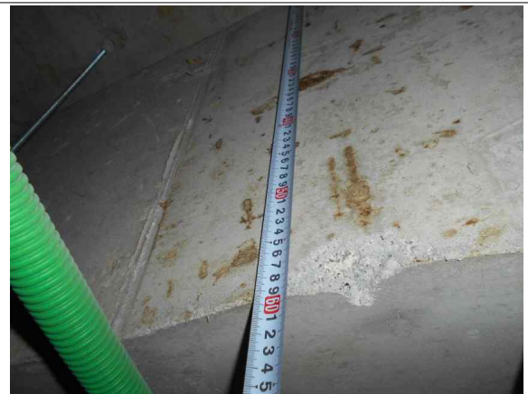
지상3층 바닥 보 G1 규격 조사 현황
