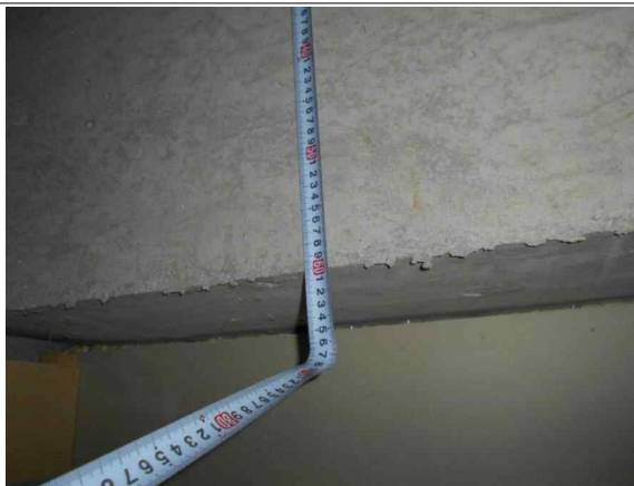
지상4층 바닥 보 G1 규격 조사 현황
