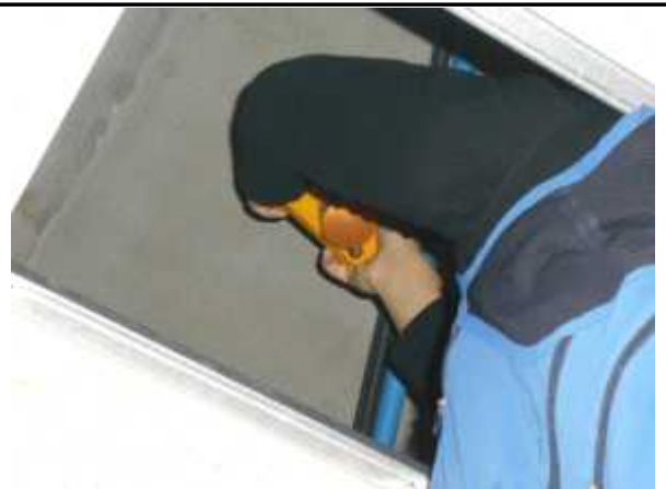
슬래브 콘크리트 압축강도 조사 현황
